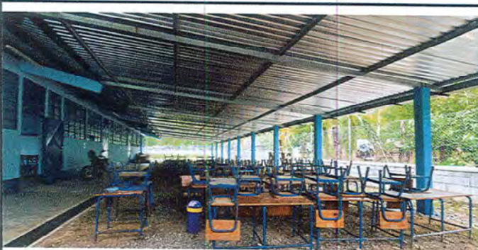
Foto 3: Se puede observar la ampliación del corredor terminada en su totalidad
