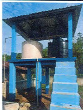
Foto 2: Se puede observar la construcción de la galera que servirá para resguardar y mantener el alto los depósitos de agua para la adecuada distribución, así mismo se puede observar el pintado del mismo.
